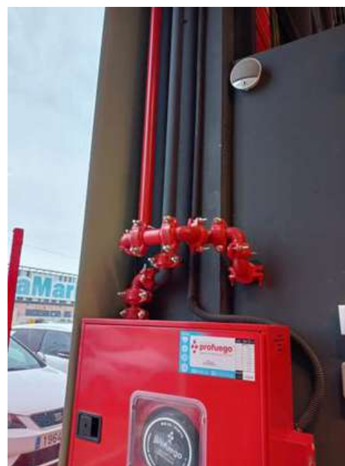
Instalación del Sistema de Protección Automática contra incendios en Tienda Kiwoko Ondara
