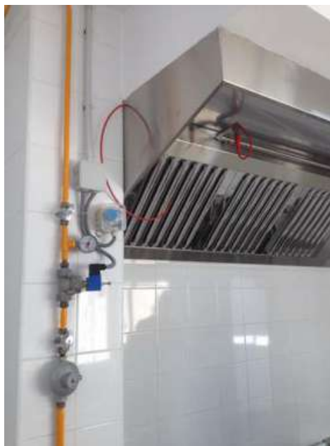
Instalación Sistema Extinción Automática en cocina de un colegio en Benidorm
